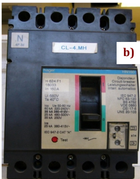
Fig. 20: Interruptores automáticos de B.T. a) Modulares de 2 polos (izquierda) y de 3 polos (derecha) b) De caja moldeada de 4 polos
