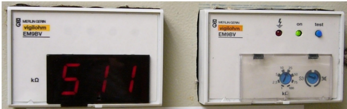
Fig. 44: Controlador permanente de aislamiento
