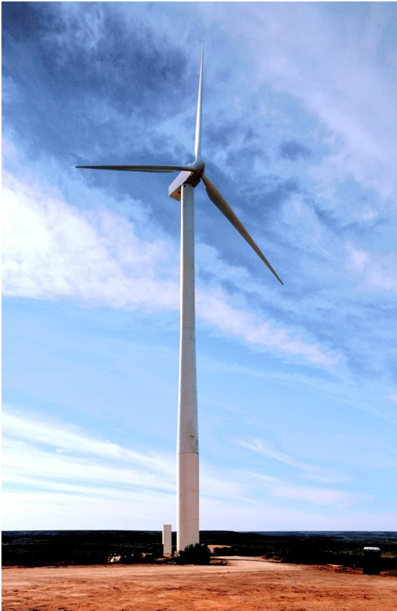
Aerogenerador sobre torre tubular
