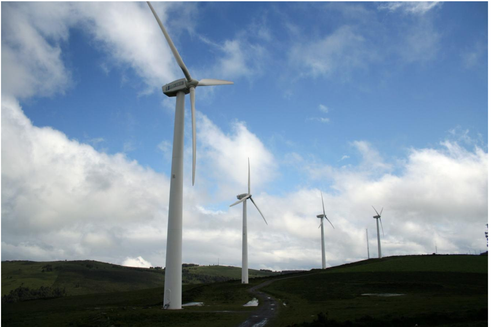
Parque eólico donde los aerogeneradores están instalados sobre torres tubulares
