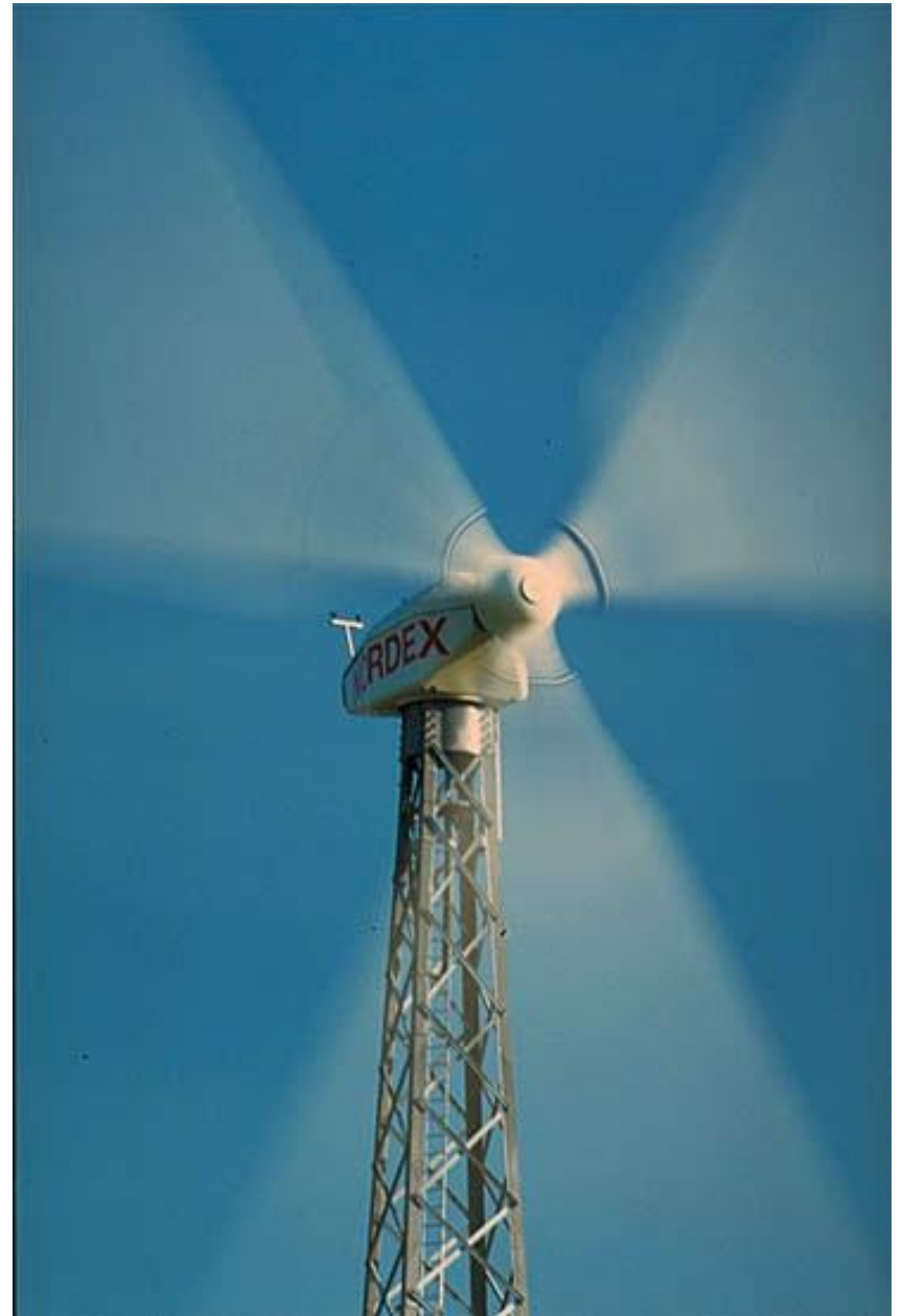
Aerogenerador sobre torre de celosía
